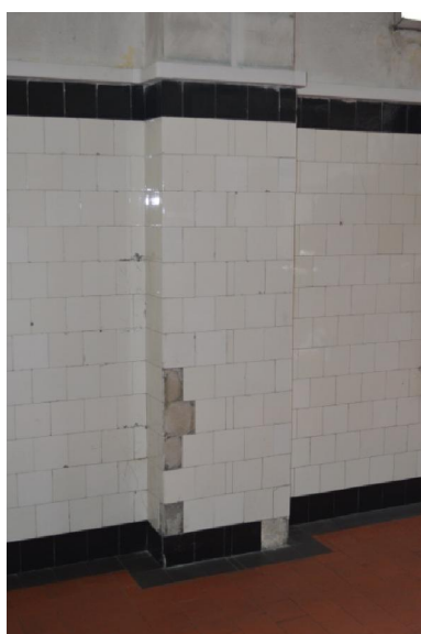
FOTO č.13: MVE I chybějící obklad
